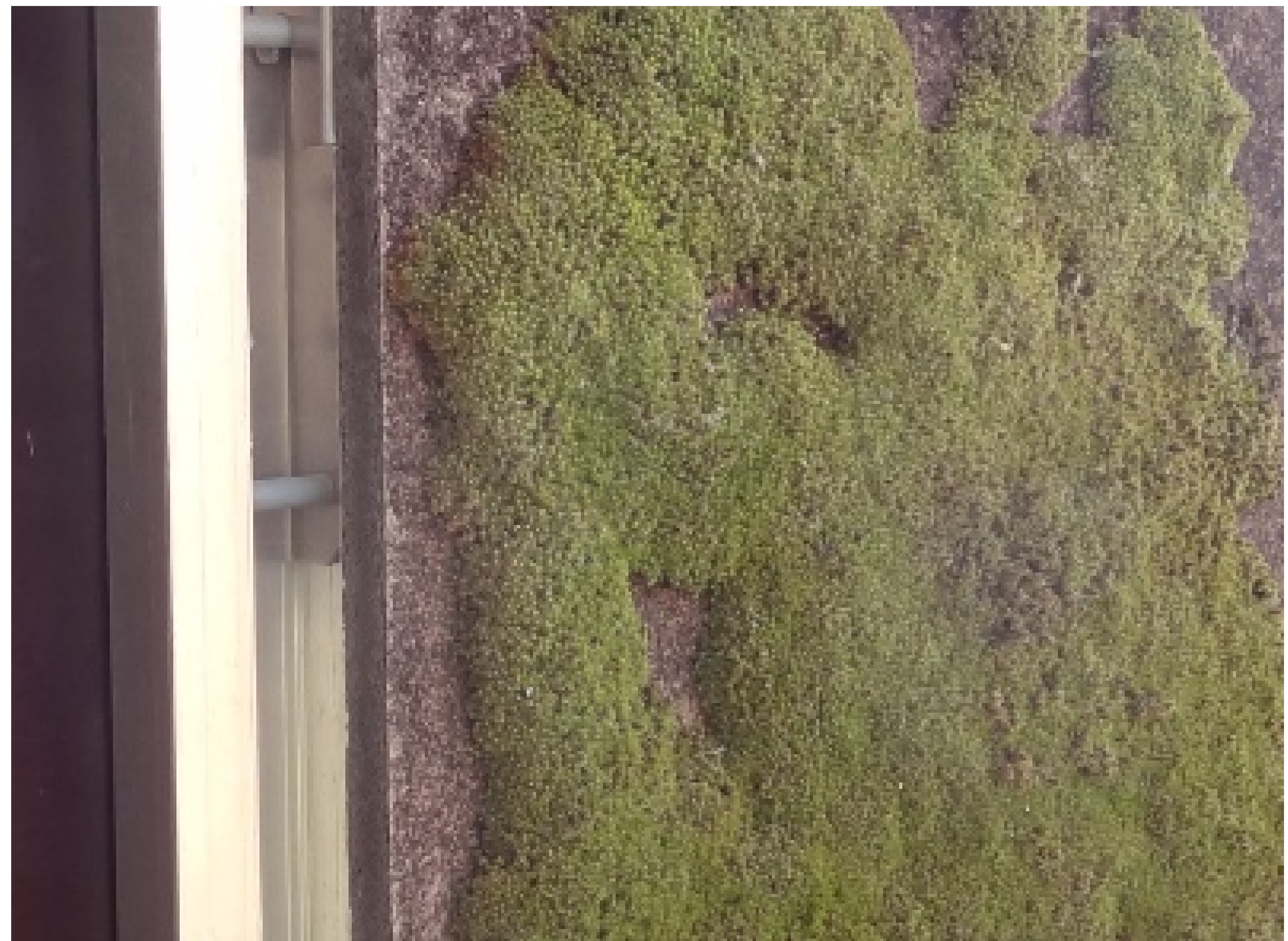
Détail de la solution : bardage rapporté végétalisé à base de mousses
