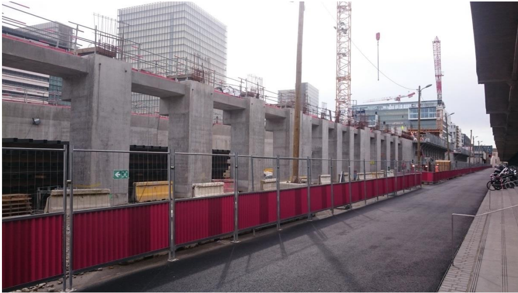
Rue Ada Lovelace provisoire – vue vers le parvis Alan Turing – 12.09.2017 (à droite, le mur proposé se dessine par ces éléments de ferrillage)
