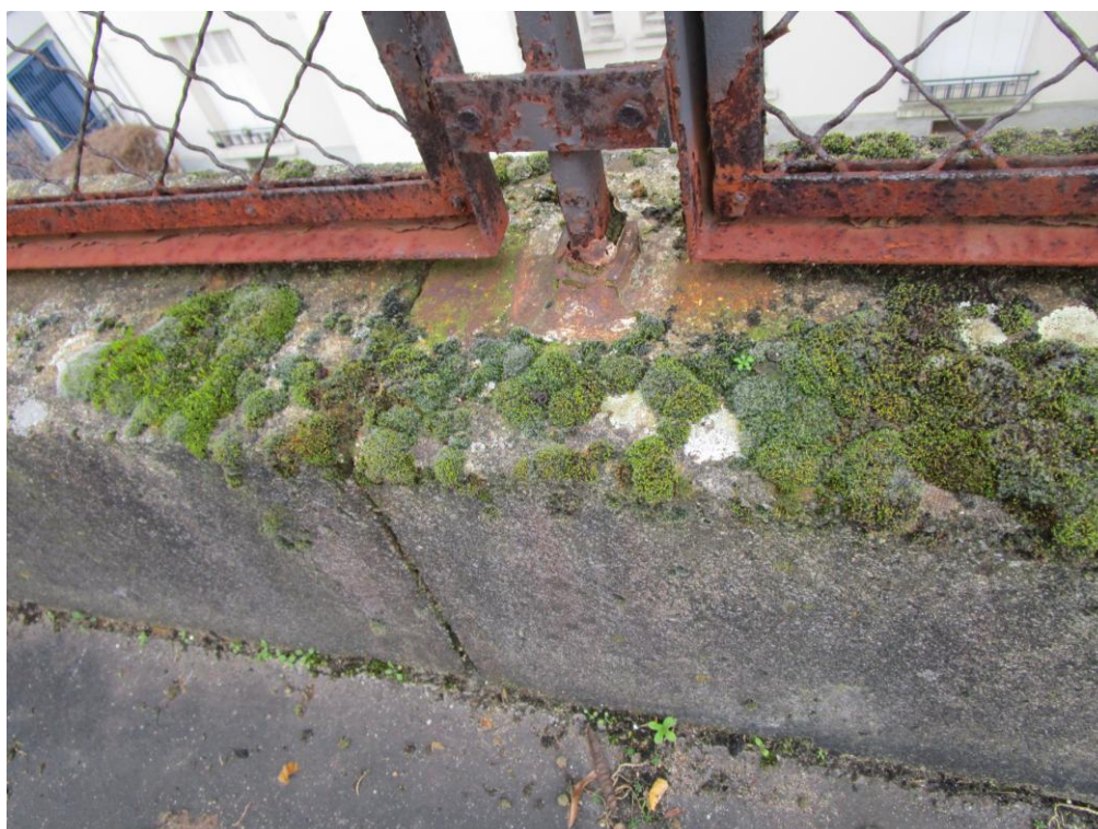
Photo 8 – Détail ancrage du grillage sur acrotère
