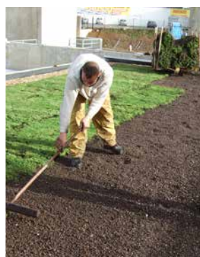
Nivelage du substrat
