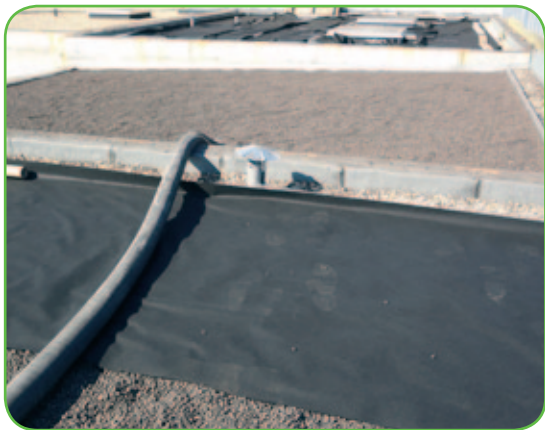
Pose de la nappe i.D. FILTRE sur la couche filtrante
