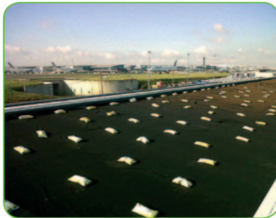
Nappe i.D. FILTRE lestée avant la répartition du substrat
